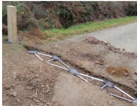
Ejemplo de instalación con sensor PIR0 para peatones y un bucle ZELT para bicicletas
